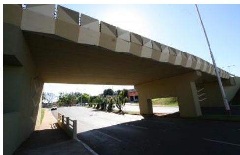
FIGURA 4 – Intervenção- Viaduto Origami
