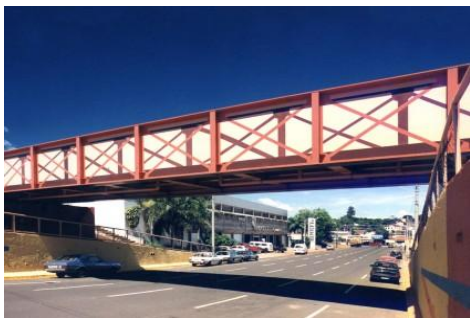
FIGURA 3 – Intervenção – Viaduto Sombras
